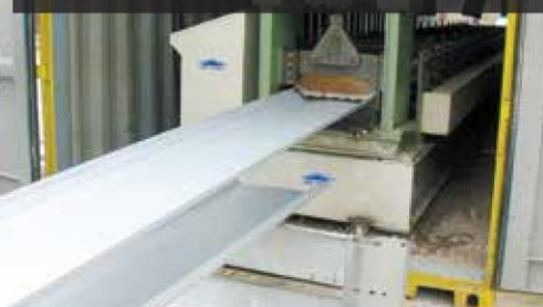
Gia công Lokseam tại công trường
